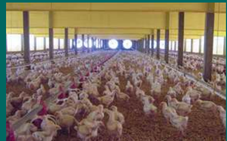
Foto 1. En los sistemas de ventilación por túnel los deflectores estacionales incrementan la velocidad del aire.
